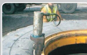
7 Separar el anillo cónico (aro cuchillo) de la pestaña (flange)
