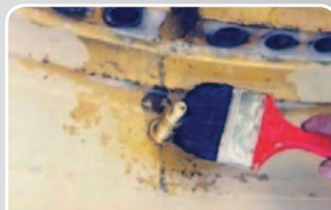
14 Verificar la hermeticidad (que no existan fugas de aire)
