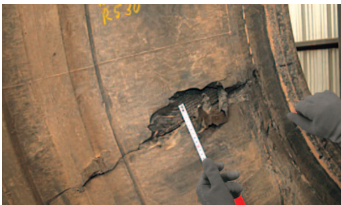
Antes de la reparación
