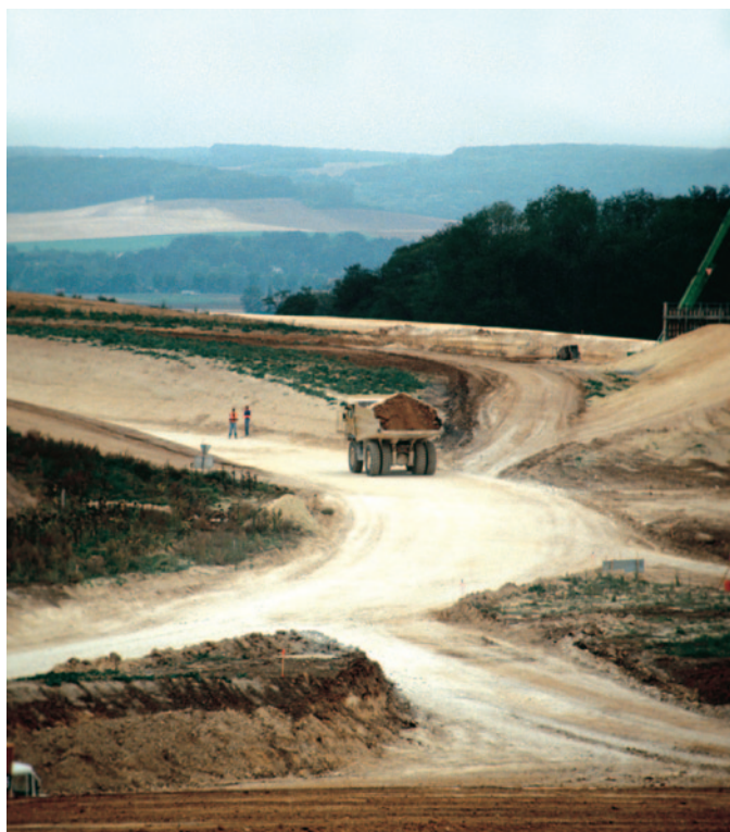
Un trazado adecuado de las pistas limita el desgaste en cono
