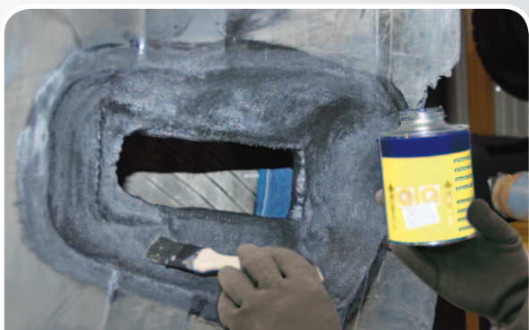
Aplicación de una mezcla para cementar
